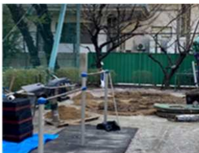
雲梯の工事がありました
